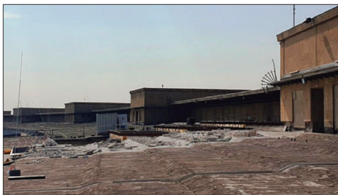
Die Dachsanierung geht weiter und soll voraussichtlich im Frühjahr 2027 beendet werden.
