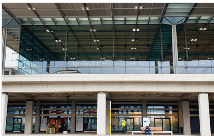
...zum BER soll es mit der Dresdner Bahn jetzt schneller gehen. Fotos: MH
